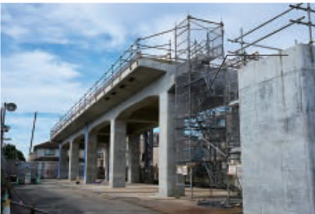
高架橋構築状況(代田橋7号踏切西側)
