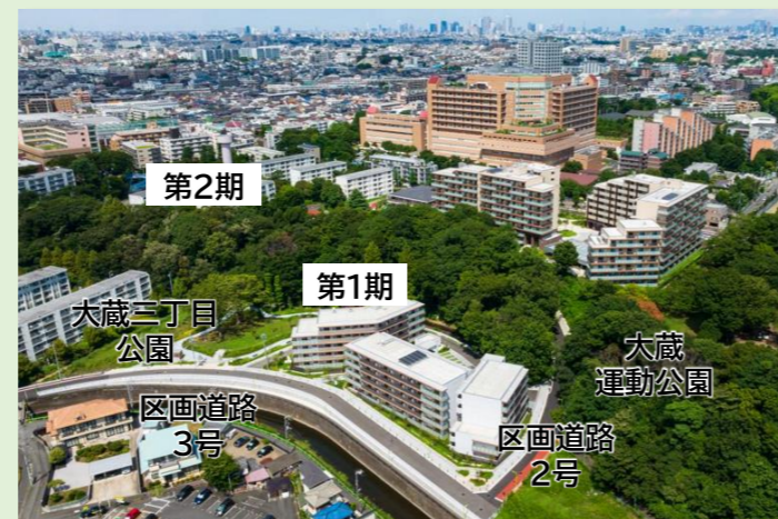
地区全景(写真提供:JKK東京)
