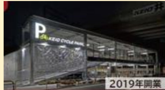
京王井の頭線高架下に整備された自転車等駐車場「京王サイクルパーク下北沢」(370台)
