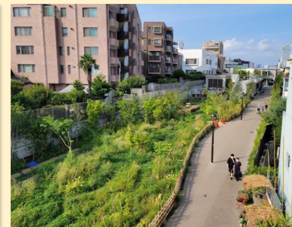
通路及び緑地・小広場(R3完成)
