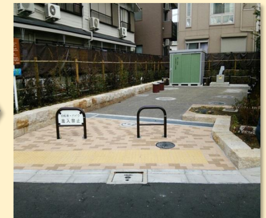
マンホールトイレなどを備えた小公園を整備
