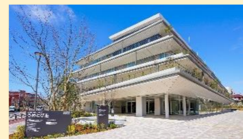
保健医療福祉総合プラザ(R2完成)
