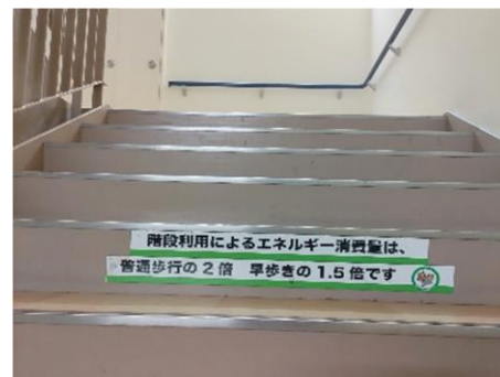
砧総合支所 庁舎内の階段
