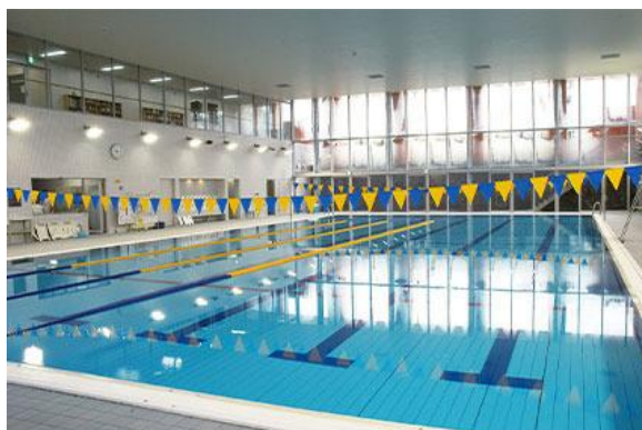
烏山中学校温水プール
