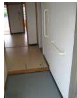
住宅改修後の玄関の様子
