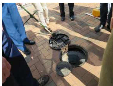
区立施設内のマンホール トイレ整備事例
