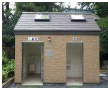
公衆トイレの整備事例
