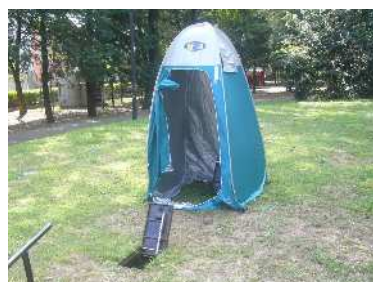
公園内のマンホールトイレ
