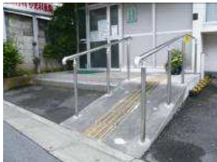
段差解消のスロープを整備した事例
