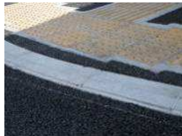
整備された歩道の出入口部分
