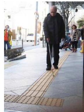
誘導用ブロックの敷設確認の様子
