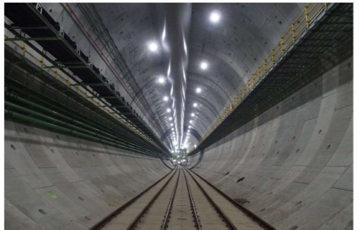
シールド内部状況 (令和5年6月27日)
