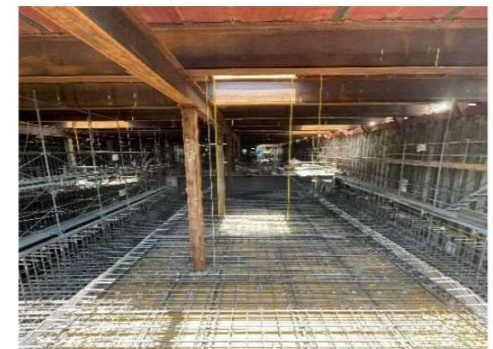
Hランプ躯体構築の状況 (令和5年5月18日)
