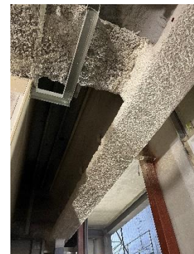
吹付け工法の耐火被覆
