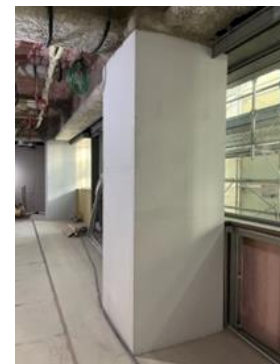
ボード工法の耐火被覆
