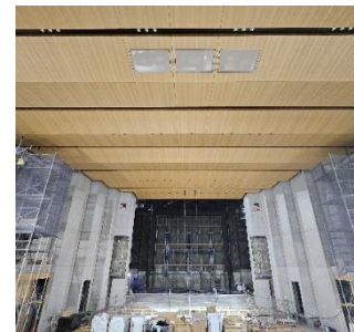
ホール・舞台の施工状況
