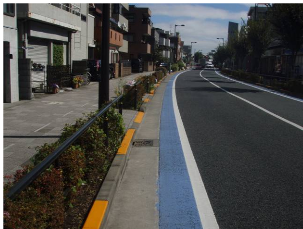
図4-4 自転車走行帯の整備事例(補助209号線・三軒茶屋一丁目)
