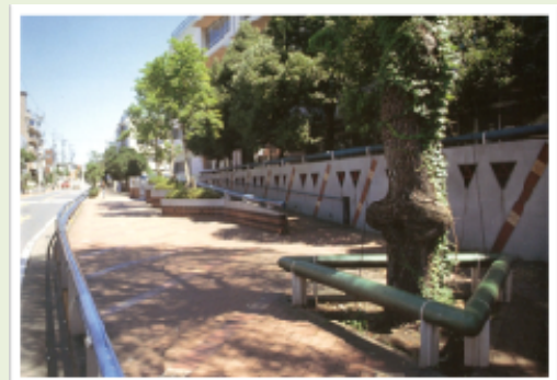
梅ヶ丘駅周辺やさしいまちづくり整備 (公共施設や福祉施設が集まる梅ヶ丘駅周辺ではゆとりある歩道の確保や段差の解消など、誰もが使いやすい公共施設整備を実施。梅丘中学校の生徒による「草花タイル」が彩りを添えている。)
