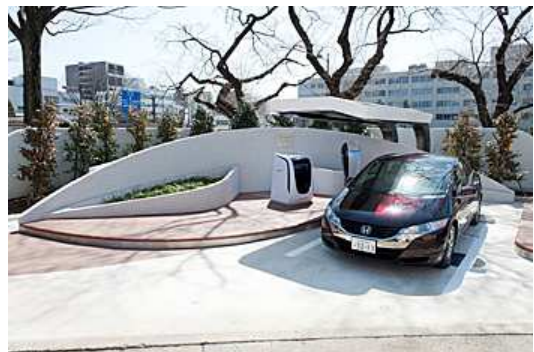
図 49 ソーラー水素ステーション
