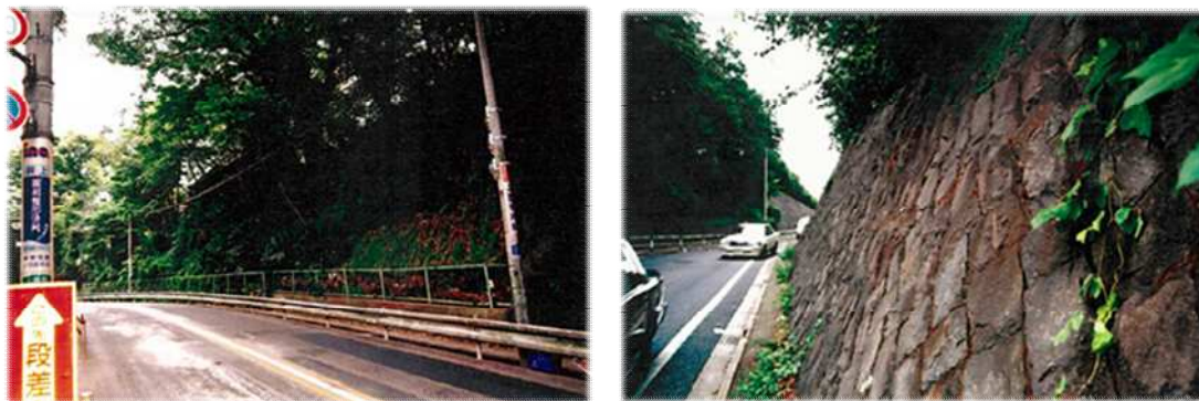
道路防災総点検箇所の例
