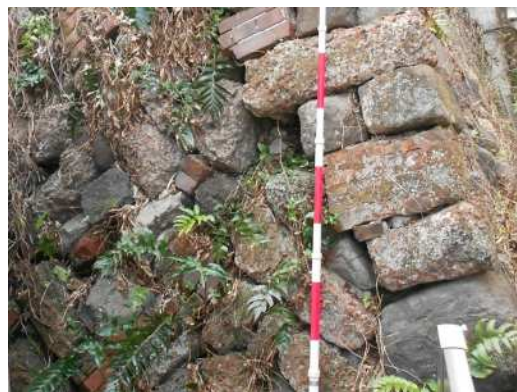
瓦礫等の廃材を利用した擁壁の例
