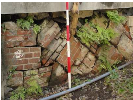
瓦礫等の廃材を利用した擁壁の例
