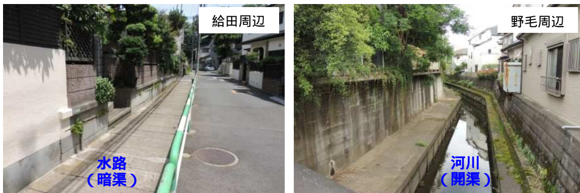
護岸上に分布する擁壁の例
