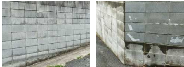
コンクリートブロック積擁壁
