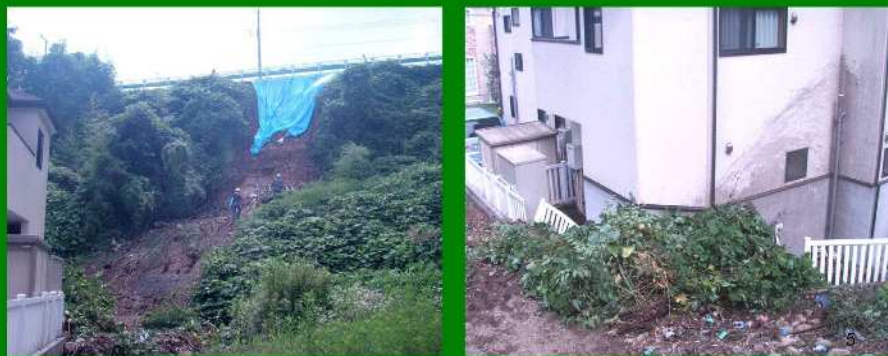
東京都内の急傾斜地崩壊の事例
