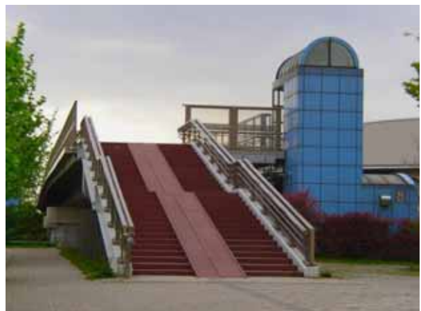
上部デッキから下につなぐ階段 + エレベーター
