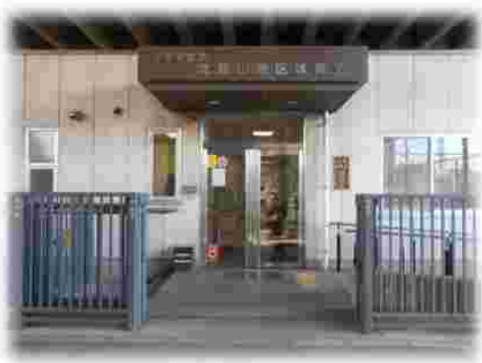
北烏山地区体育室
