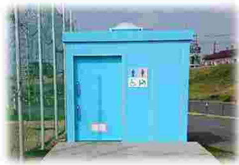
だれでもトイレ (二子玉川緑地運動場)
