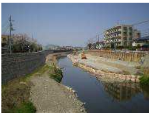
野川における河川整備工事前後の状況(左:平成 21 年 4 月、右:平成 29 年 9 月)
