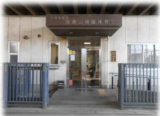
北烏山地区体育室
