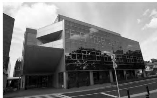
第3庁舎オープン (1992) 出典：世田谷Web写真館
