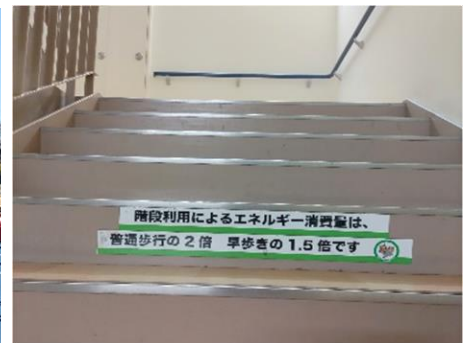
砧総合支所 庁舎内の階段
