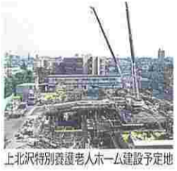
上北沢特別養護老人ホーム建設予定地
